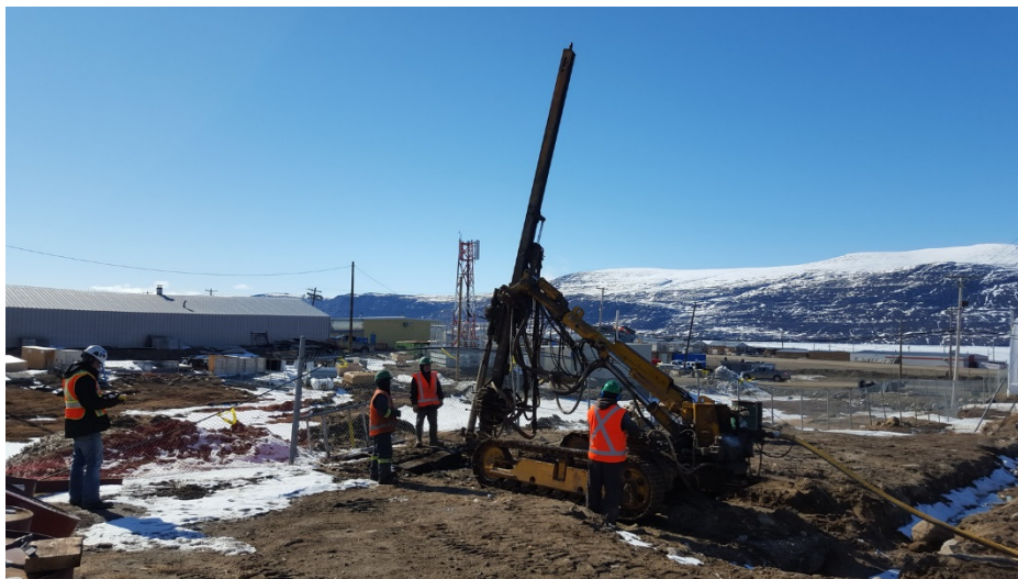
Installation d'un pieu de fondation sur le chantier de reconstruction de la centrale de Pangnirtung
