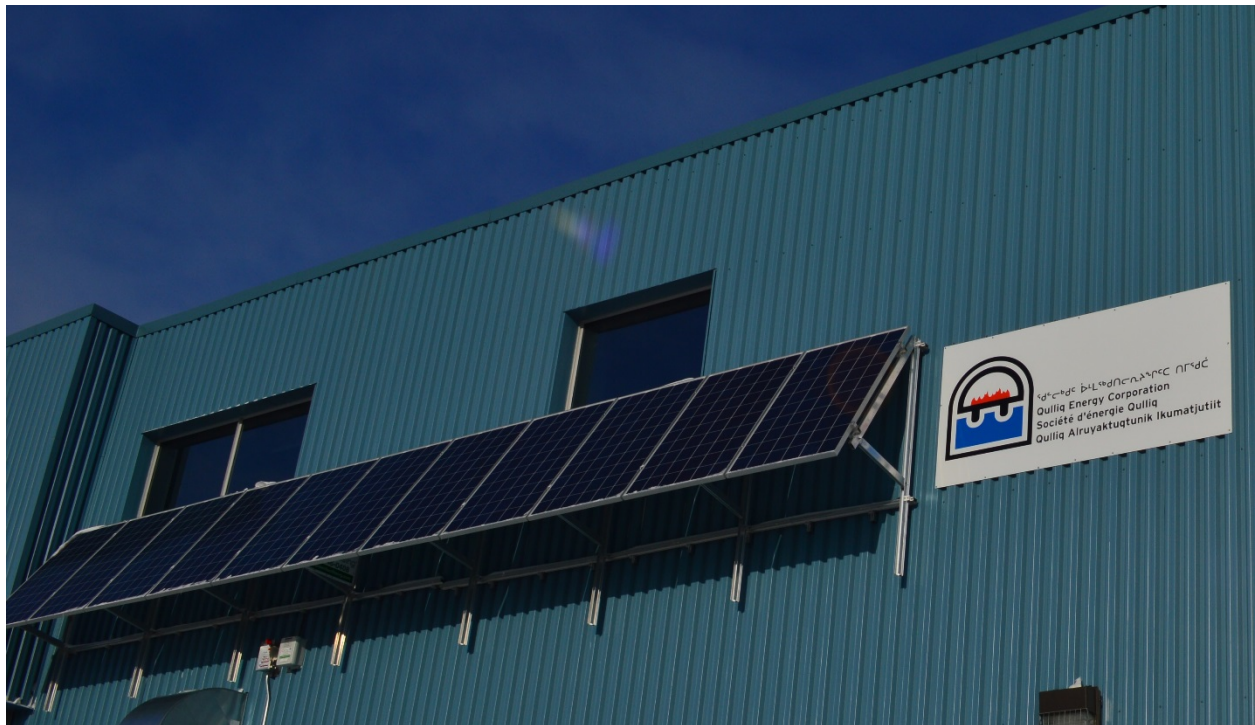
Panneaux solaires sur la centrale d'Iqaluit
